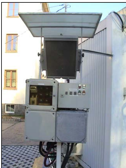
Bilder 3 und 4 Steuerungs- und Regelungstechnik der Solar-Stirling-Anlage Anlagenregelung und Kühlkreislauf (Bild 3) sowie Verbrauchersteuerung (Bild 4)
