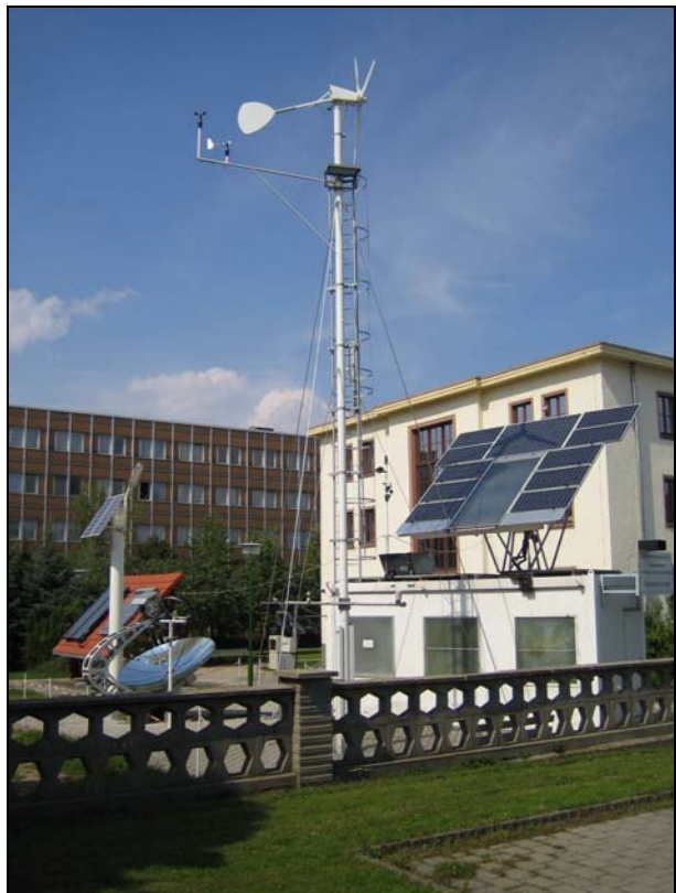
Bild 1 Der Komplexversuchsstand „Regenerative Energien“ der HTWK Leipzig, Fb ME
