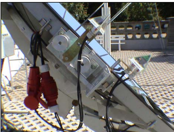
Bild 11 Strahlungspyranometer der zweiachsig Nachführeinrichtung
