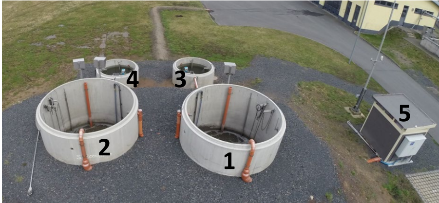
Abbildung 2 – Versuchskläranlage zur Reinsauerstoffnutzung aus der Wasserelektrolyse, (1 – Bele-bungsbecken 1; 2 – Belebungsbecken 2; 3 – Nachklärbecken 1; 4 – Nachklärbecken 2; 5 – Maschinenhaus mit Anlagen zur Luft- sowie Reinsauerstoffversorgung und EMSR-Technik).
